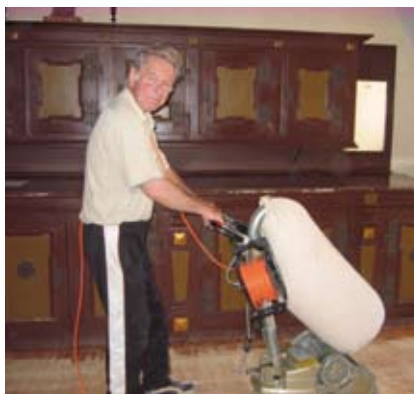
Heinz Bollmann beim Abschleifen des Fußbodens in der Sakristei.
